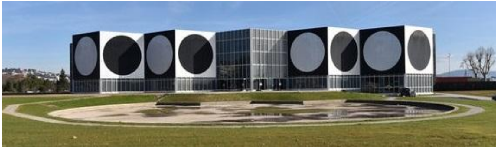
Fondation Vasarely - Aix-en Provence 1971-1976
