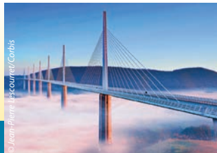
Le viaduc de Millau (France), le pont le plus élevé au monde.
