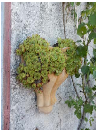
Détail de la façade de la maison.
