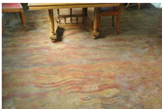
Sol en ciment.
