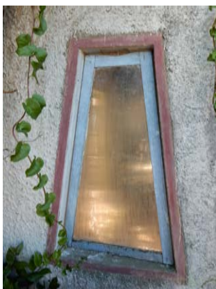
Fenêtre en forme de trapèze sur la façade de la maison.
